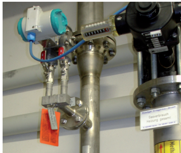
deltaflow für Biogasmengenmessung
